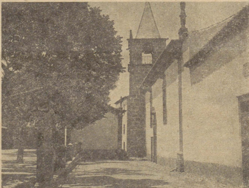
Vista de uma parte da praça de São Vicente da Beira, lateral, sul da Igreja Matriz, torre, e vendo-se ao fundo a parede, costas da Capela da Misericórdia ou Capela do Senhor Santo Cristo.
