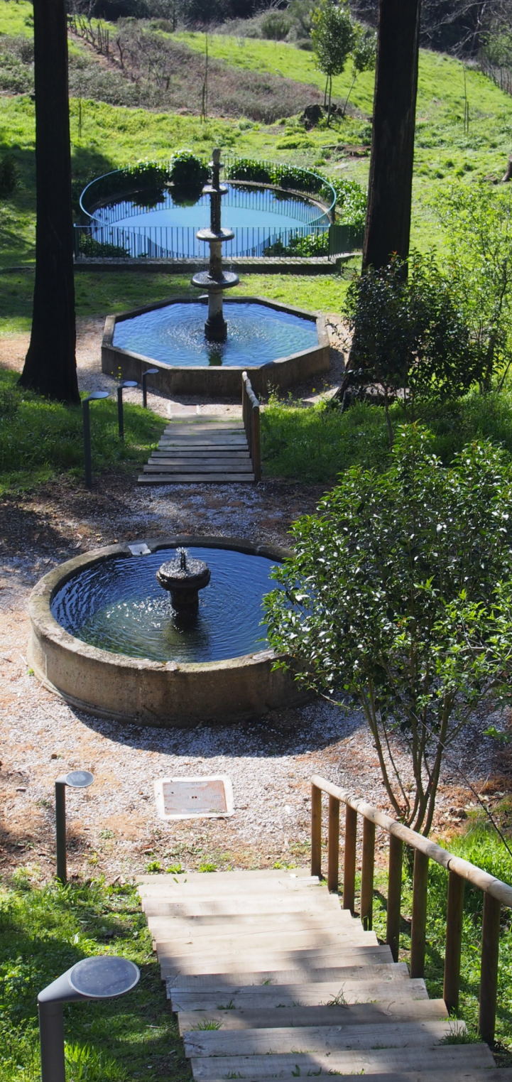
VISTA GERAL DOS TANQUES DO JARDIM
